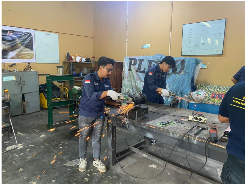
Gambar 6. Pemotongan dan perataan benda kerja
