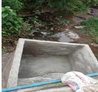
Gambar 4. Hasil Akhir Pembuatan Tempat Pembuangan Sementara
