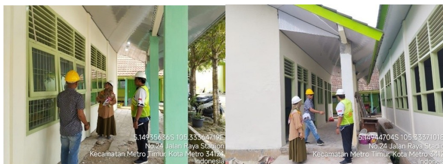
Gambar 4. Monitoring pekerjaan fisik terbangun
