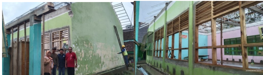
Gambar 3. Monitoring pekerjaan fisik terbangun
