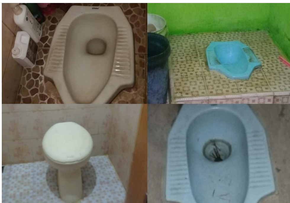
Gambar 4. Kondisi Jamban Warga Kelurahan Way Gubak
