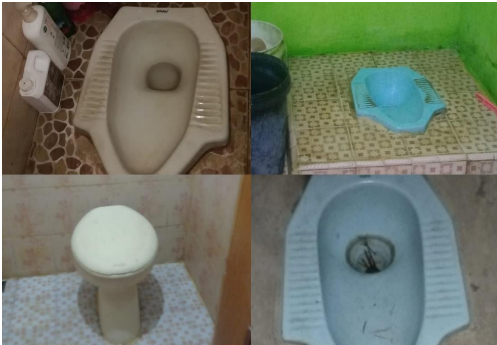
Gambar 4. Kondisi Jamban Warga Kelurahan Way Gubak
