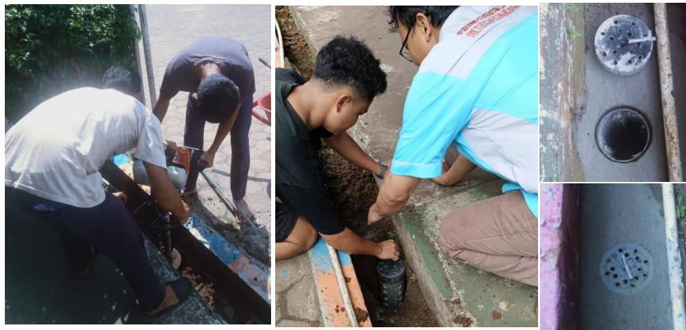
Gambar 4 Proses pembuatan Lubang Biopori
