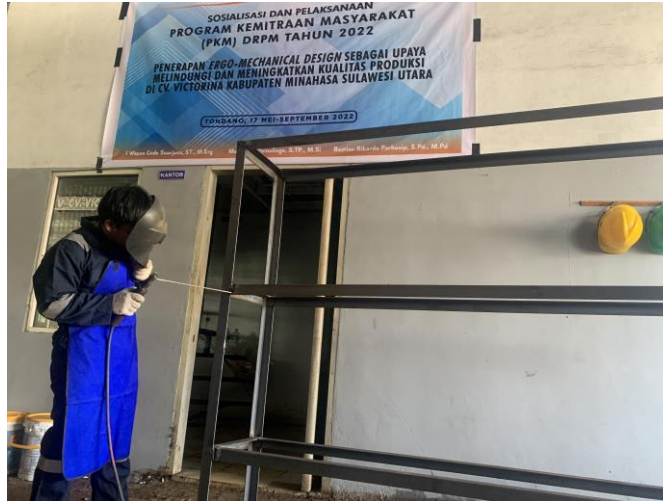
Gambar 4. Penggunaan APD pada saat melakukan Pekerjaan
