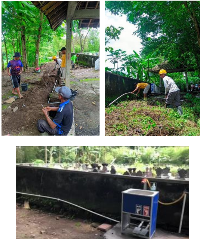
Gambar 4 Proses pengadaan tempat cuci tangan dan instalasi air
