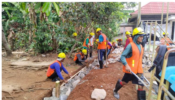
Gambar 7. Praktik Pemasangan Batu Pondasi
