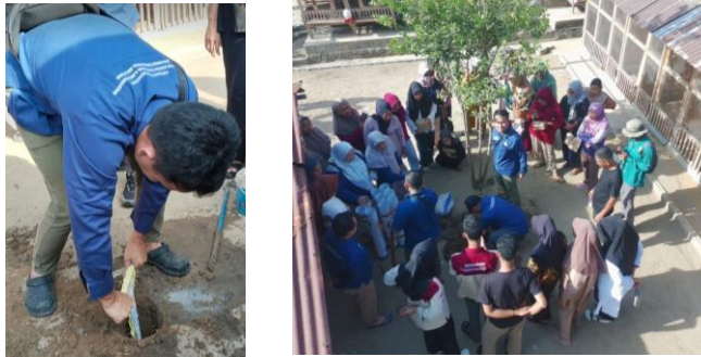
Gambar 4. pelubangan tanah dengan bor tanah
