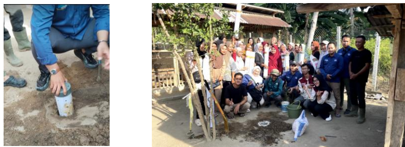
Gambar 5. pemasangan pipa biopori dan pengisian sampah organik Adapun gambaran pengetahuan kader kesehatan sebelum dan setelah diberikan edukasi dapat terlihat pada table 1 dibawah ini
