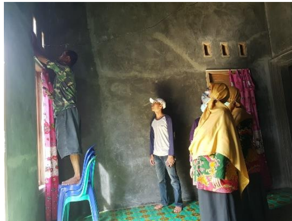
Gambar 4. Kegiatan pemasangan kawat nyamuk pada ventilasi.
