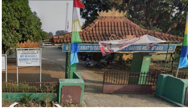
Gambar 1. Bangunan SD 2 Negeri Gadingrejo Utara
