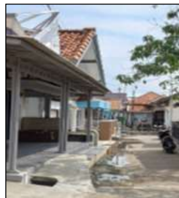
Gambar 2. Peninggian Lantai Teras
