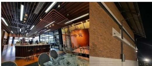
**Gambar 3. Interior tanpa plafon pada ceiling**
